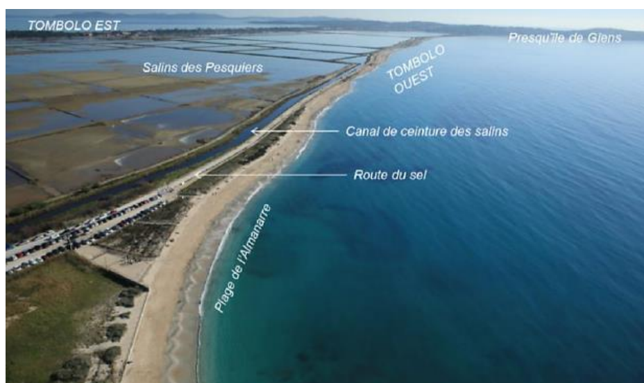
9 - Vue aérienne du site - Etude ARTELIA « Définition de travaux pour la protection du tombolo ouest et de la route du sel » - Octobre 2017
